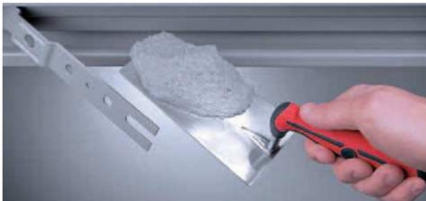
En cas de fixation par les pattes de fixation, il est conseillé de créer des entailles dans le support (section 80 x 200 mm), ou de fixer les pattes avec des chevilles. Les pattes de fixation doivent être pliées et bloquées dans le mur. Pour une bonne tenue mécanique, le vide entre dormant et mur doit être rempli de ciment mortier ou de mousse polyuréthane.
